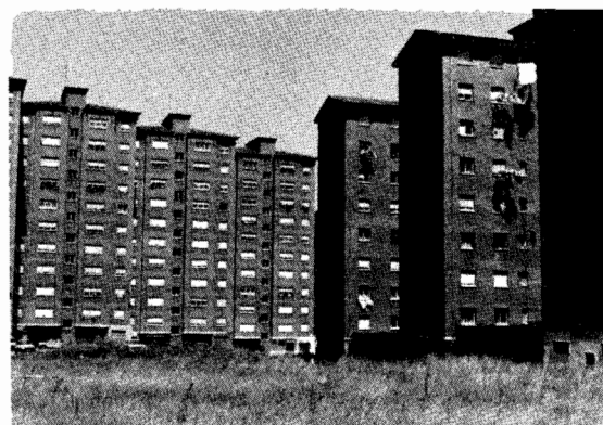
Fig. 5. La gran presencia de los bloques sencillos de doble crujía, que caracterizan morfológicamente los asentamientos periféricos alzados en los difíciles tiempos de la inmediata postguerra (véase foto en parte superior, correspondiente al Grupo La Tejerona, en Ceares), da paso en los albores del desarrollismo a las construcciones en altura, de mano del Poblado de las 1.500 viviendas del INV en Pumarín (centro). Esa tipología es ampliamente utilizada desde entonces en promociones de carácter privado. Tal como sucede con los bloques levantados por UNINSA en el Poblado de Nuevo Gijón en 1970 (abajo).
